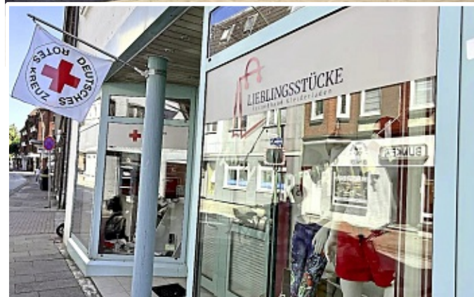
Das alte DRK-Geschäft im Flamweg: Die Räume verfügten nicht über den gesetzlich vorgeschriebenen Brandschutz. Archivfoto: Brameshuber
